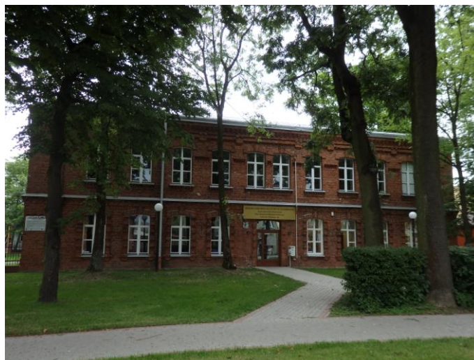
Zdjęcie nr 8. Budynek koszarowy Zespołu Koszar Szkoły Artyleryjskiej w Zambrowie (źródło: UM Zambrów)
